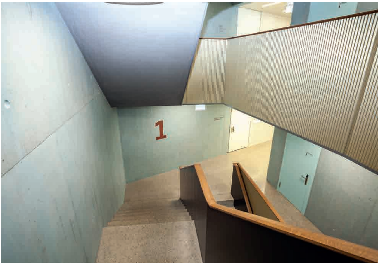
Auf engstem Raum unterstützt ein blau kolorierter Sichtbeton die großzügige Wirkung im Treppenhaus des Rathauses von Altstätten.
