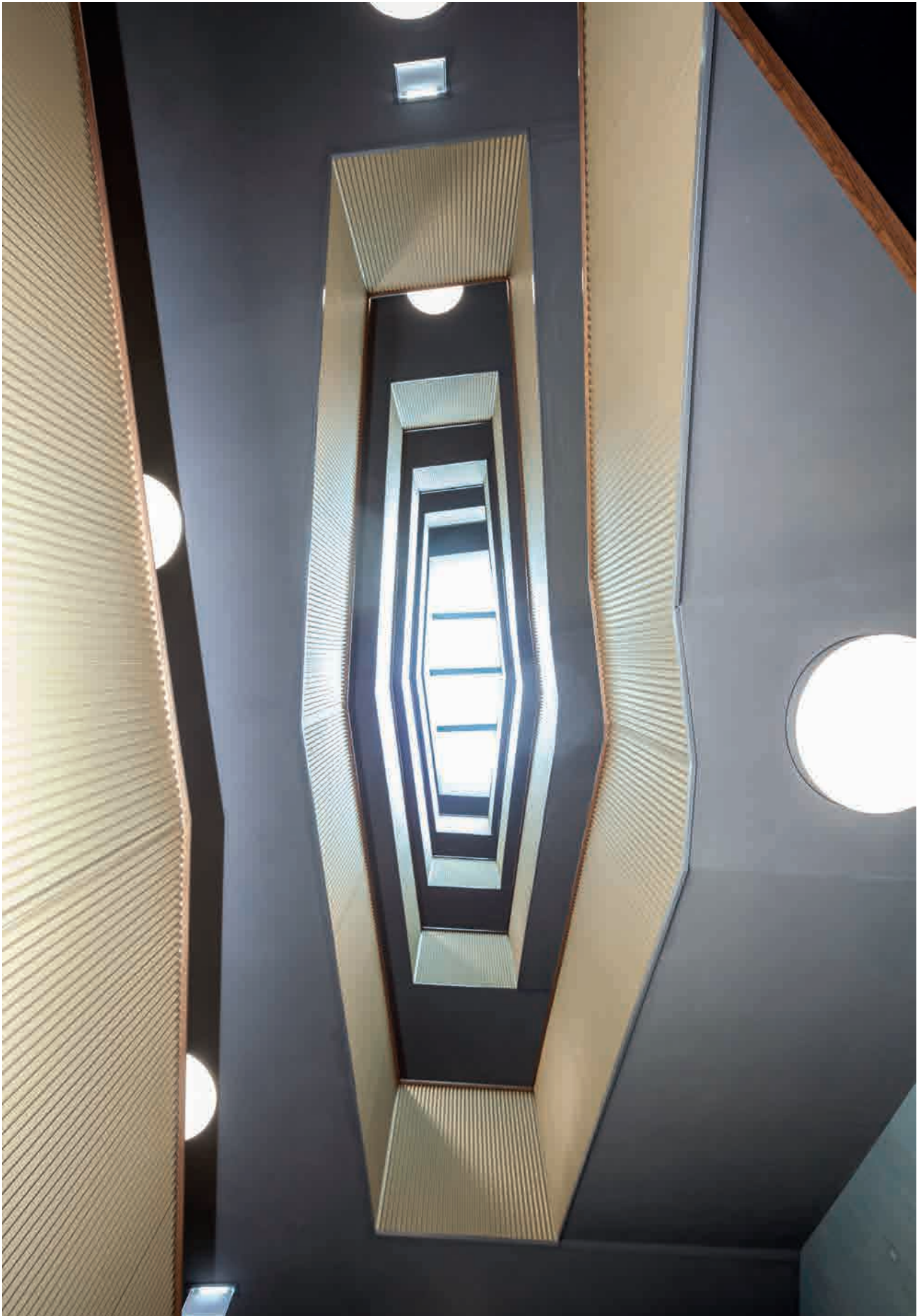
Taillierte Treppenläufe und Geschossdecken vergrößern das Treppenauge
