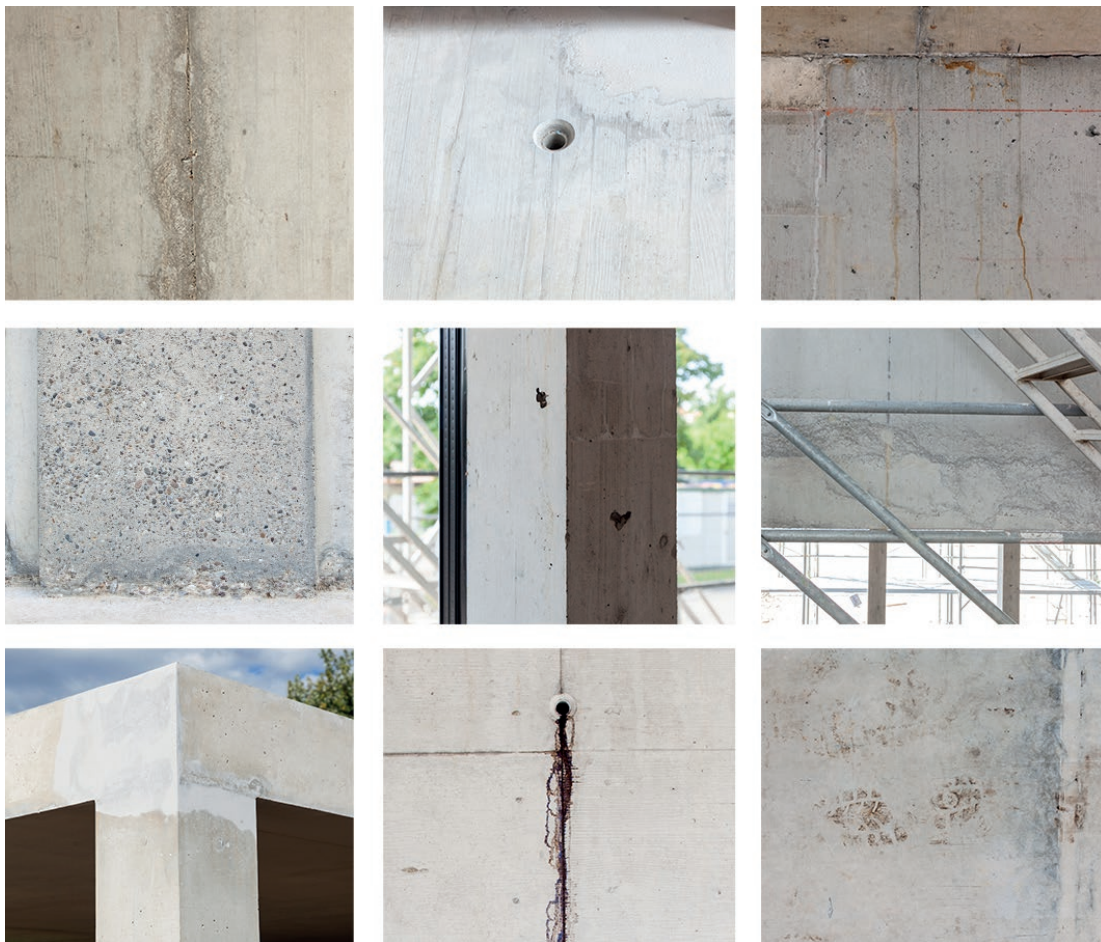
Typische Schadensbilder im Überblick: Rote Markierungsstriche kreuzen Zementläufer, Schüttlinien, Fußabdrücke, Kiesnester etc.
