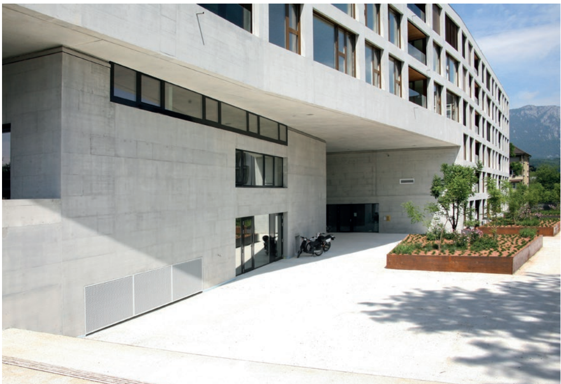
Das Ergebnis stimmt – schöner homogener Sichtbeton. Punktuelle Schadstellen sind korrigiert und die gesamte Betonfläche mit der Betonlasur facial Colour für ein homogenes Oberflächenbild koloriert.
