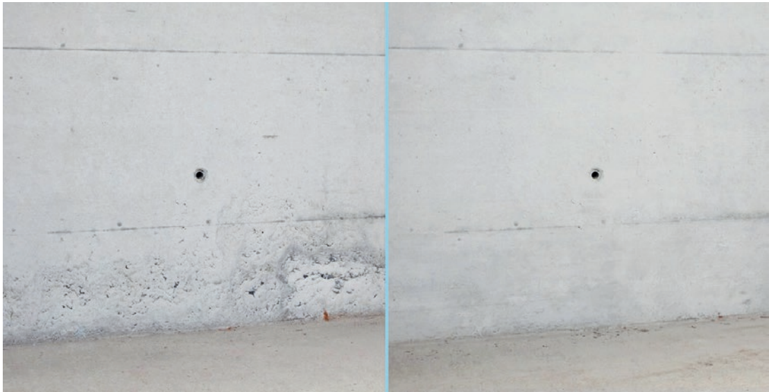
Vorher/nachher-Abbildungen zeigen die erfolgreiche Beseitigung eines Kiesnestes durch Betonkosmetik
